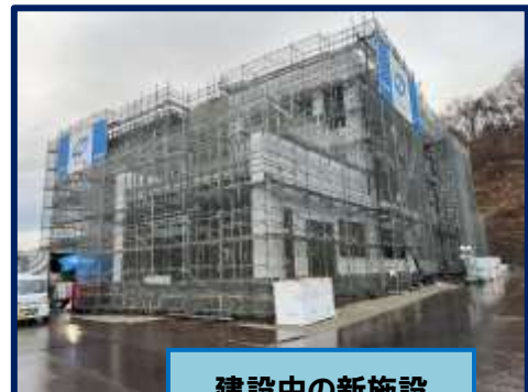
建設中の新施設
